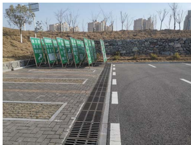
主体工程区排水沟、浆砌石挡墙
