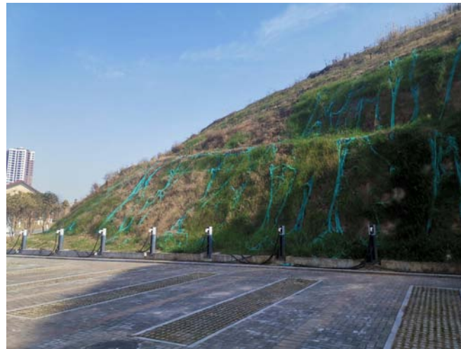
开挖边坡临时苫盖、植被护坡
