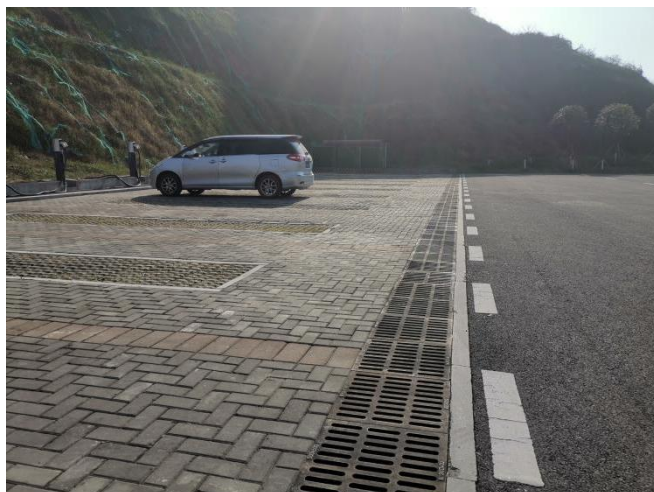
主体工程区土地平整、排水沟
