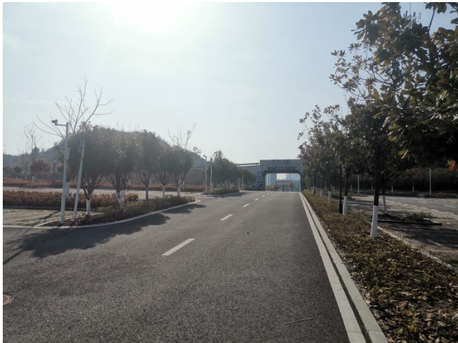
主体工程区景观绿化
