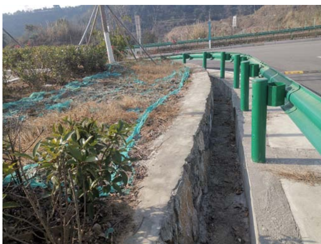
主体工程区排水沟
