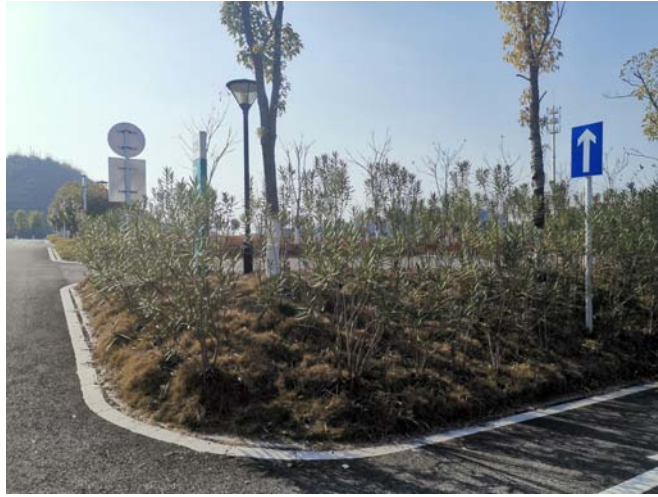
主体工程区景观绿化
