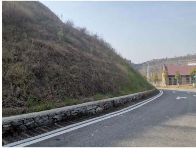
开挖边坡生态护坡、坡脚挡墙及排水沟
