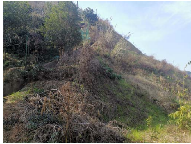
开挖边坡生态护坡、坡顶截水沟
