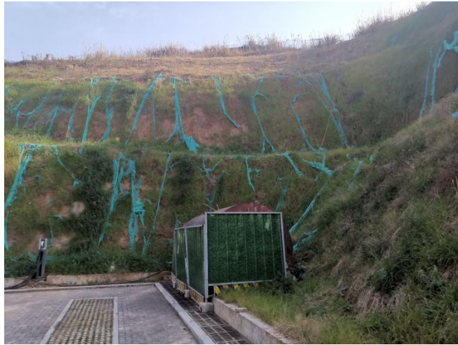
开挖边坡临时苫盖、植被护坡
