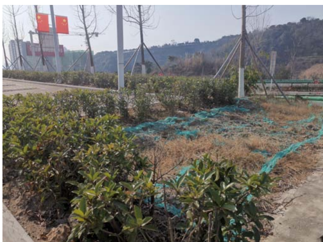
主体工程区临时苫盖
