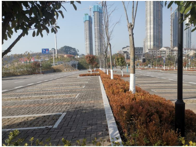
主体工程区景观绿化
