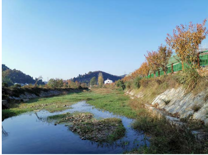
管道工程区河道整治恢复
