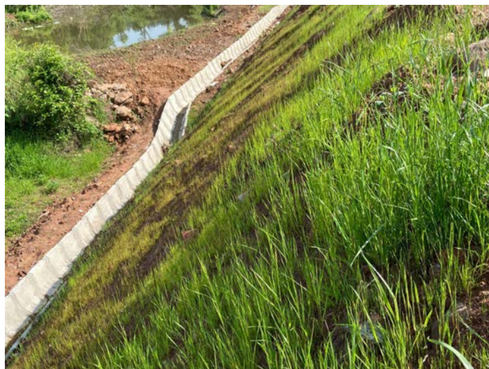
管道工程区排水沟、边坡植被恢复
