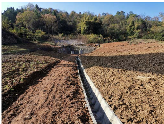
管道工程区土地平整、排水沟
