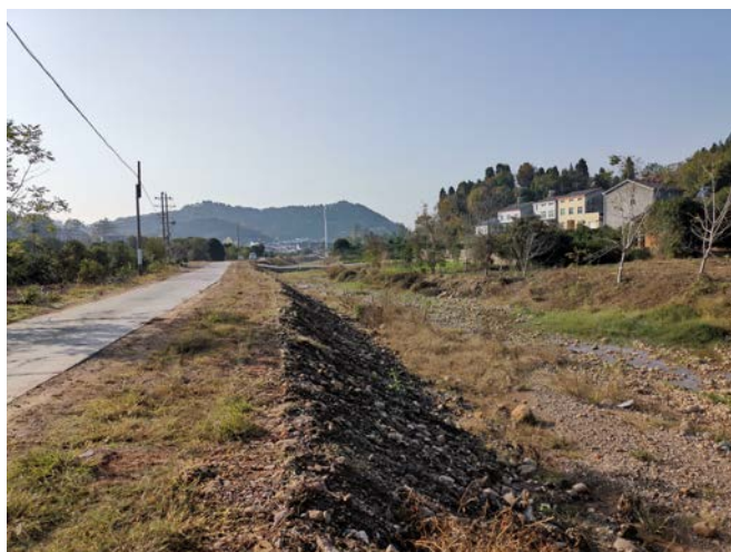
管道工程区河道整治恢复
