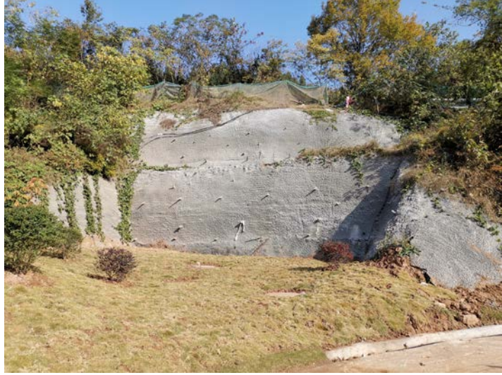
隧洞工程区隧洞口边坡喷护、截水沟
