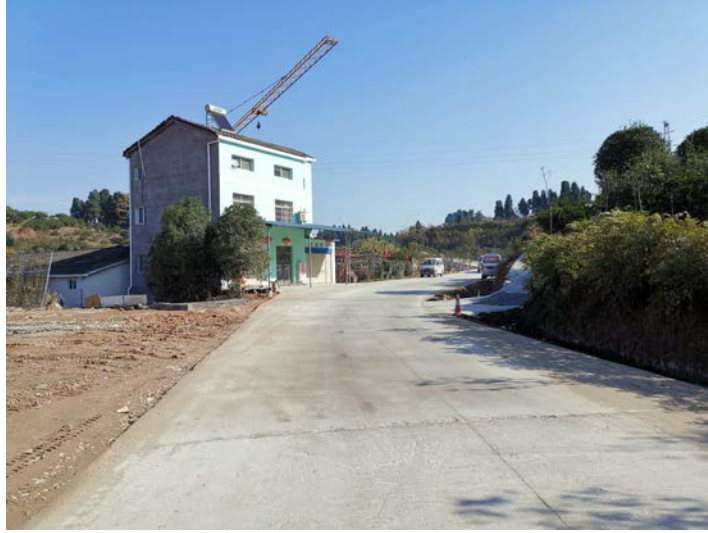
管道路面恢复
