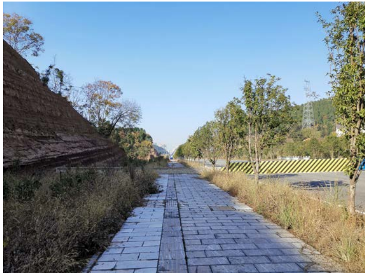
管道路面恢复
