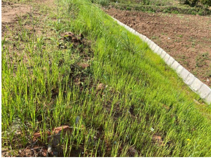
管道工程区排水沟、边坡植被恢复
