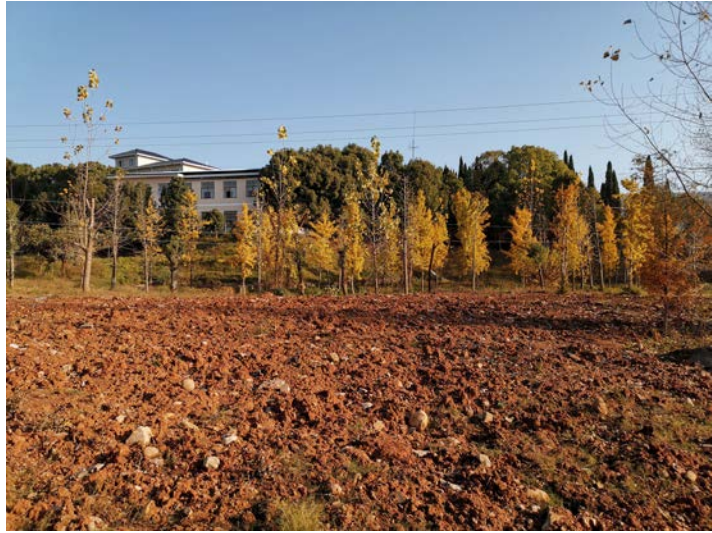
施工生产生活区土地平整
