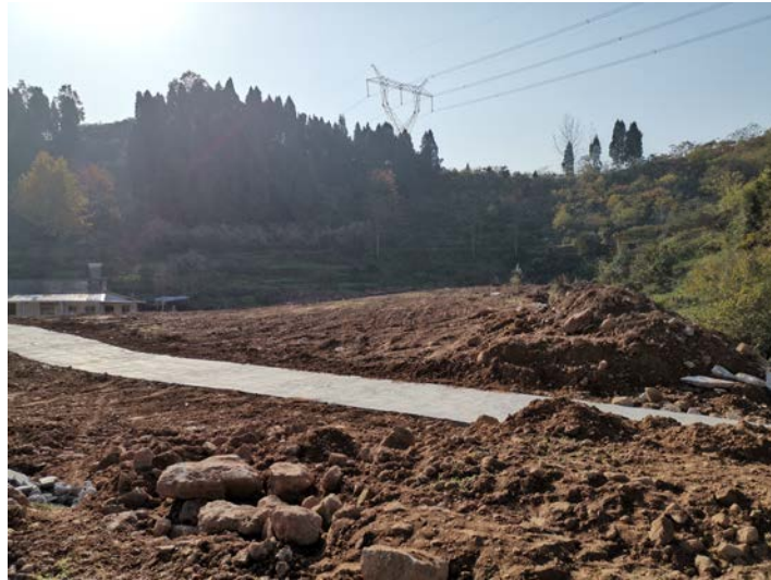
弃渣场区场地平整
