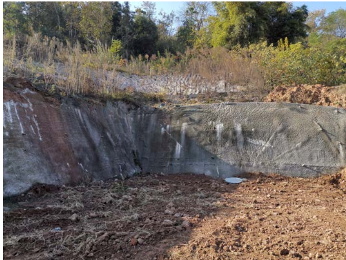
隧洞工程区隧洞口边坡喷护、截水沟
