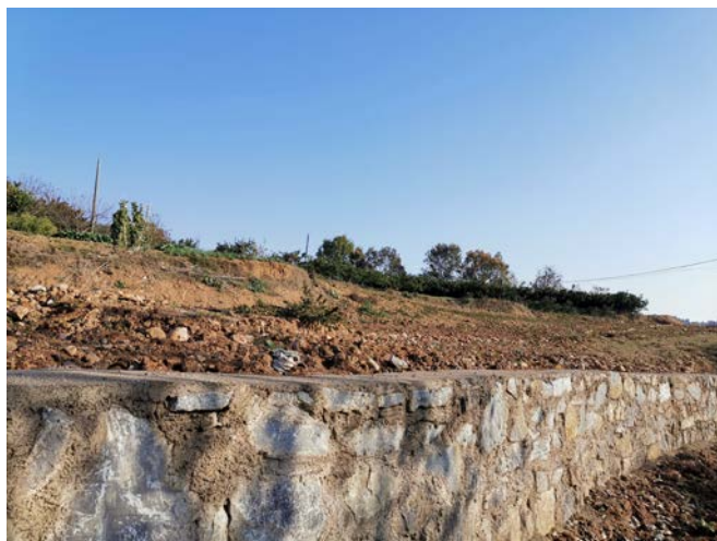
管道工程区土地平整、浆砌石挡墙、排水沟
