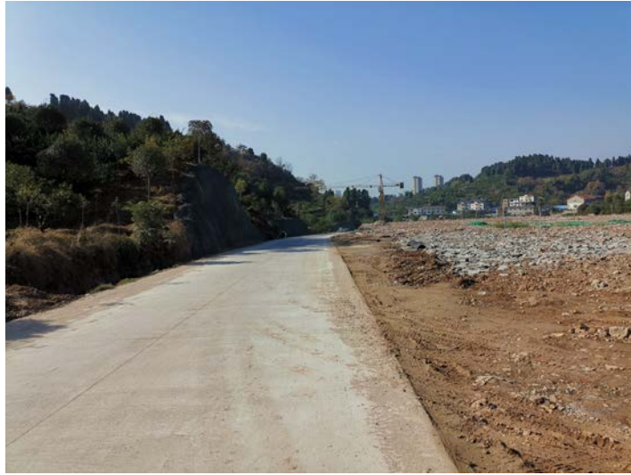
管道路面恢复
