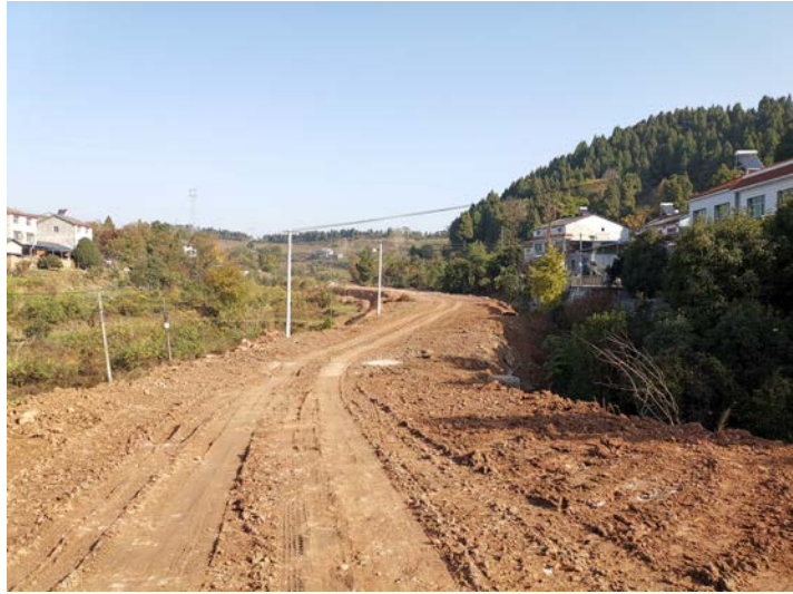
管道路面恢复
