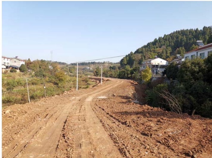
施工道路区土地平整
